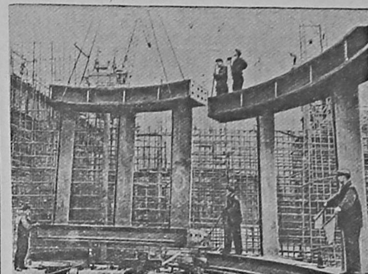
На строительстве Куйбышевского гидроузла начался монтаж и установка первых гидроагрегатов. Бригады квалифицированных монтажников успешно ведут эту работу.
